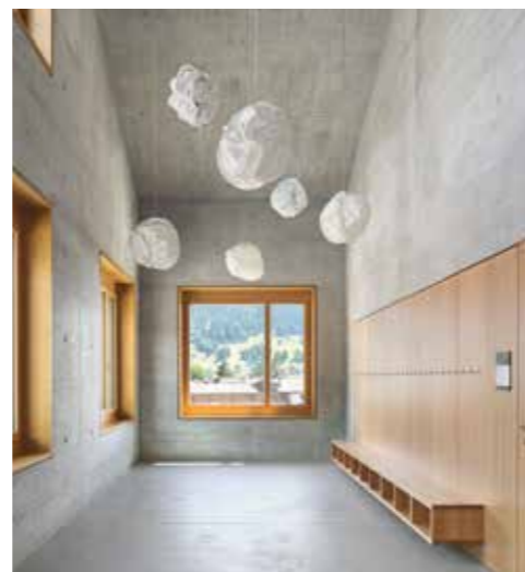
Glatter Sichtbeton mit beispielbaren Akustikholzeinlagen
